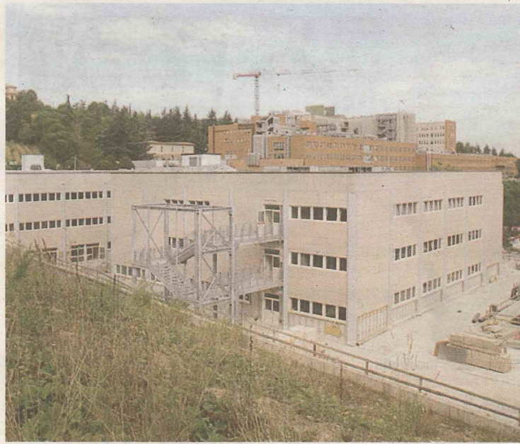
Una gru sospesa sul Bufalini all'epoca della costruzione della Piastra
