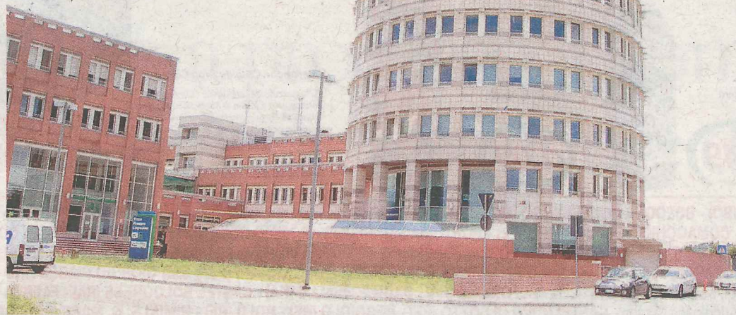
DIREZIONE La sede di Banca Romagna Cooperativa al Centro Montefiore
